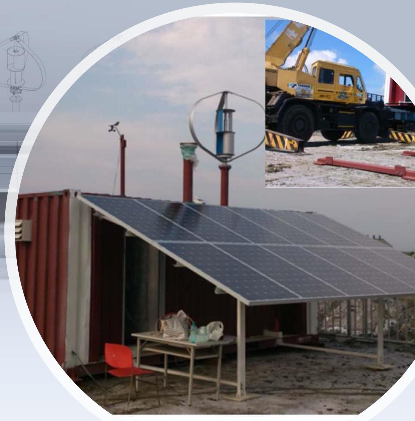
Ogni container da 20 "può includere un massimo di 4 turbine verticali da 1kW con cablaggio direttamente nel container e gestione della turbina tramite il controller mppt intelligente.
